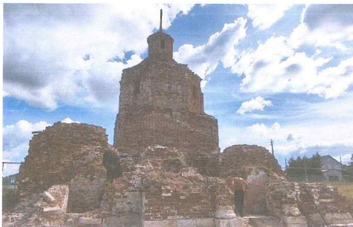
6. Разрушенный храм села Осиновка. Автор фото А. Манылова
